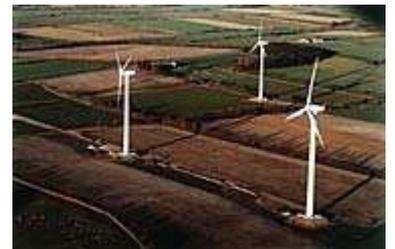
La plupart des grandes éoliennes sont livrées avec une tour tubulaire d'acier, fabriquée dans des sections de 20 à 30 m qui sont munies de brides aux deux extrémités de chacune et assemblées par des boulons sur site. Les tours sont coniques (c.-à-d. avec un diamètre croissant, plus on s'approche du pied de la tour) pour augmenter la résistance tout en utilisant moins de matériau.
